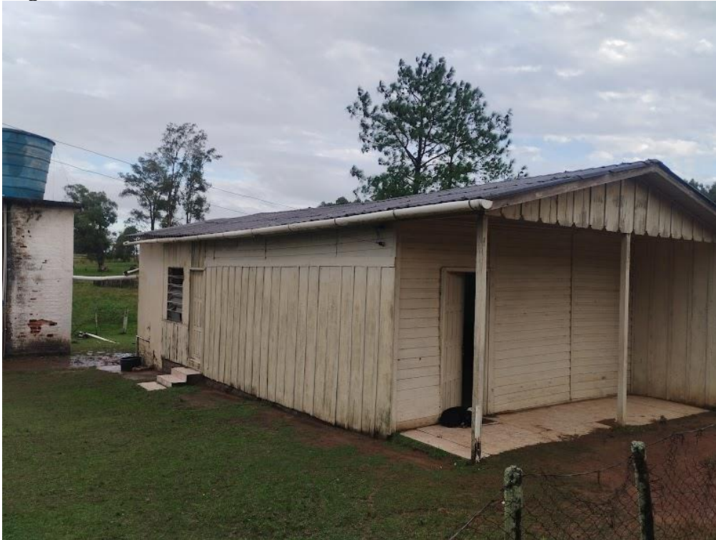
Figura 8 - Escola rural desativada.
